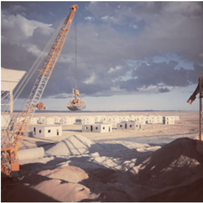
Construction d'habitations ouvrières dans le désert du Néguev, colonie de la banlieue de Be'er Sheva, Israël, 1949-1950
