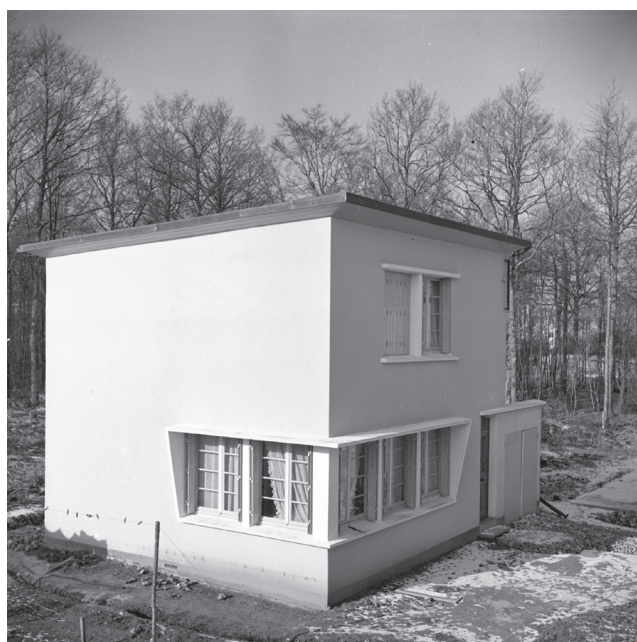
Chantier d'expérience, La Loupe (Eure-et-Loir), février 1952 Photographie : Henri Salesse
