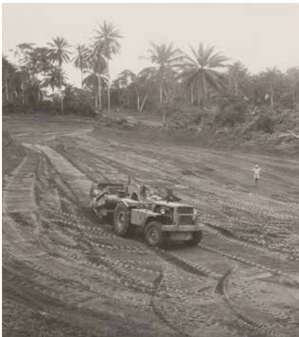
Sans titre [ Travaux de terrassement d'une route vers Dabou (Côte d'Ivoire) ], 1951 Donation François Kollar, Médiathèque de l'architecture et du patrimoine
