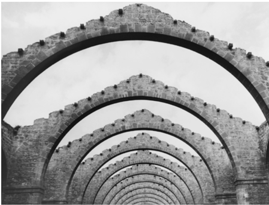
Chantier naval, Barcelone, Espagne, 1959
