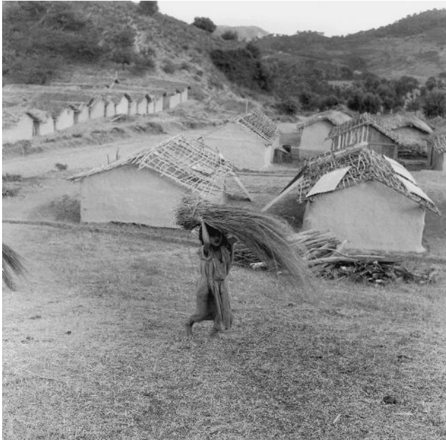
Cheraïa. Centre de regroupement en construction
