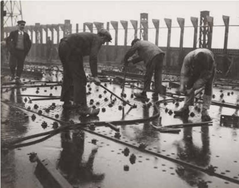
Rivetage des tôles d'un pont de navire. Chantier naval de Penhoët, Saint-Nazaire (Loire-Atlantique), 1931-1932
