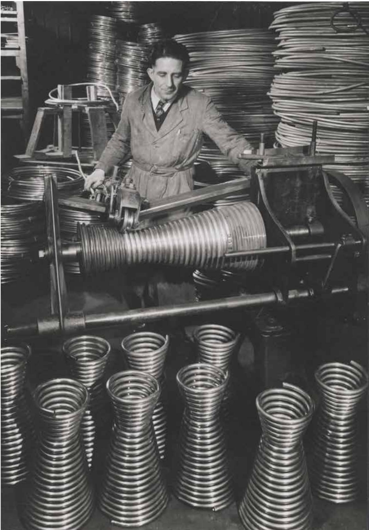
Sans titre [Fabrication de corps de chauffe de chauffe-eau,
