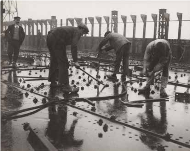
Rivetage des tôles d'un pont de navire. Chantier naval de Penhoët, Saint-Nazaire (Loire-Atlantique), 1931-1932 Donation François Kollar, Médiathèque de l'architecture et du patrimoine
