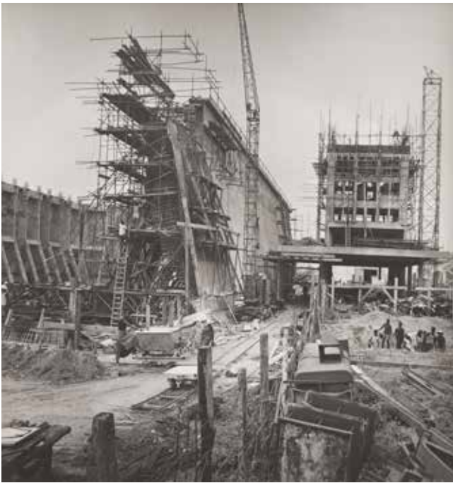
Construction d'un silo pour le stockage des arachides (Lesieur), Dakar (Sénégal), 1951 Donation François Kollar, Médiathèque de l'architecture et du patrimoine
