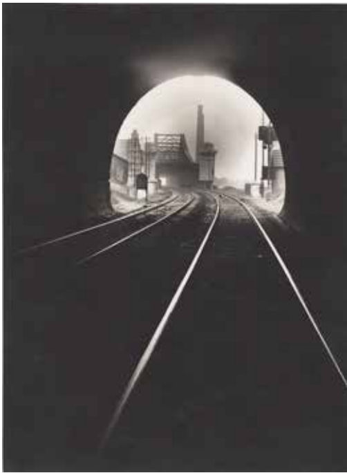
Bouche du tunnel Sainte-Catherine vers Sotteville-lès-Rouen, Rouen (Seine-Maritime), 1931-1932 Donation François Kollar, Médiathèque de l'architecture et du patrimoine
