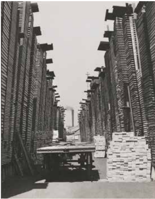
Sans titre [Empilements de traverses, usine CIMA, Croix (Nord)], vers 1954 Donation François Kollar, Médiathèque de l'architecture et du patrimoine
