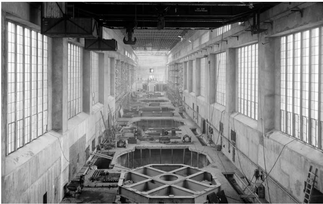
Aux sources de l'énergie. Salle des machines, Énergie électrique du Rhin, Kembs (Haut-Rhin), 1931-1934 Paris, Bibliothèque Forney © François Kollar / Bibliothèque Forney / Roger-Viollet
