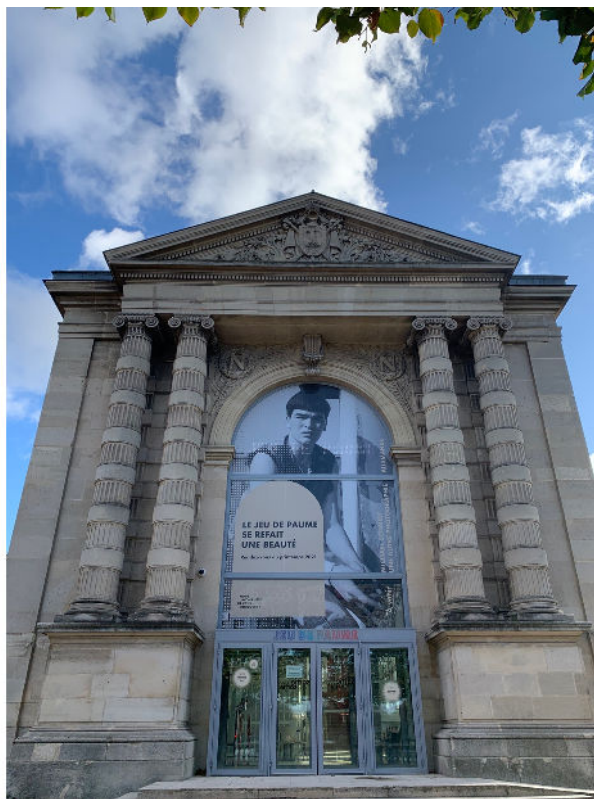
Façade - entrée principale du Jeu de Paume
